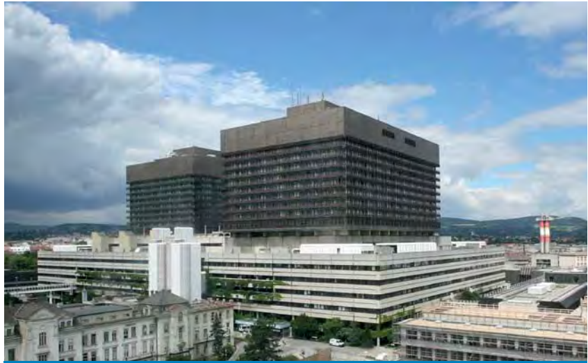
Spitäler – hier das Wiener AKH – haben eigene, riesige Notstromaggregate.
